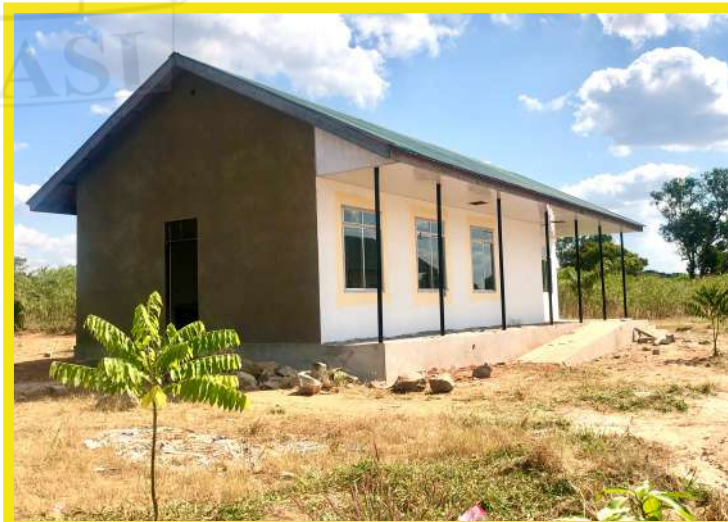
Ujenzi wa maabara shule ya sekondari Temeke
