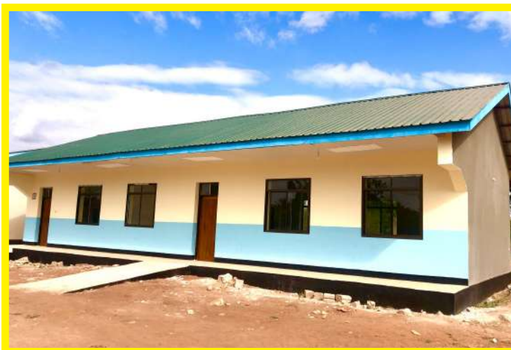
Ujenzi wa madarasa shule ya Namatunu
