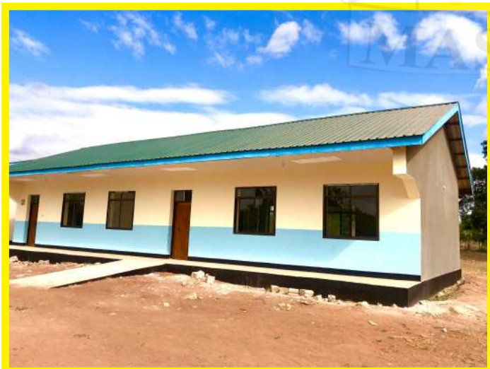
Ujenzi wa vyumba vya madarasa shule ya sekondari Temeke
